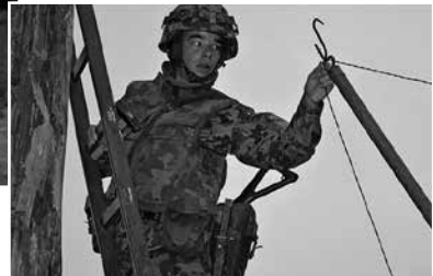
unten: Rekrut beim Leitungsbau
