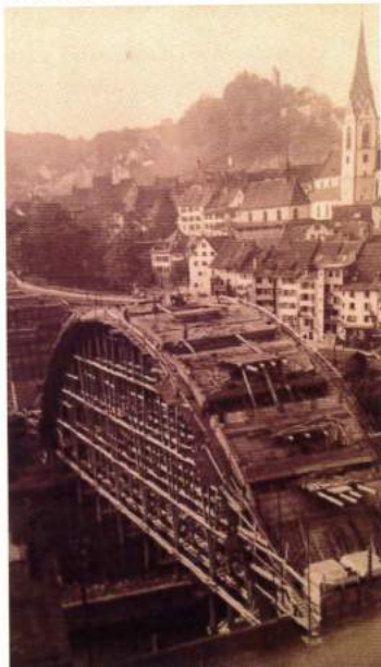
1926: Bau der Hochbrücke
